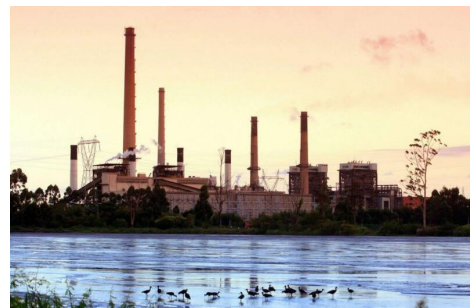
Complexo Termoelétrico Jorge Lacerda.
