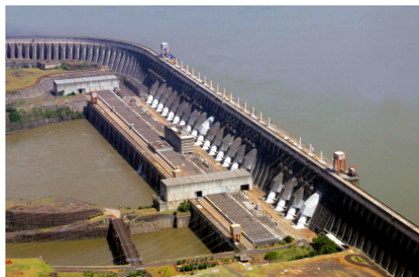
Usina Hidrelétrica de Itaipu Binacional.
