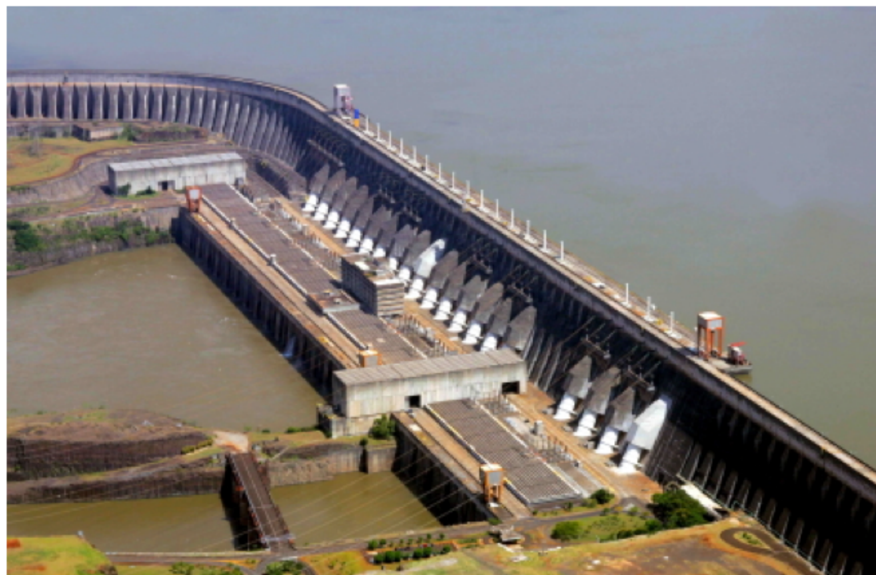
Usina Hidrelétrica de Itaipu Binacional
