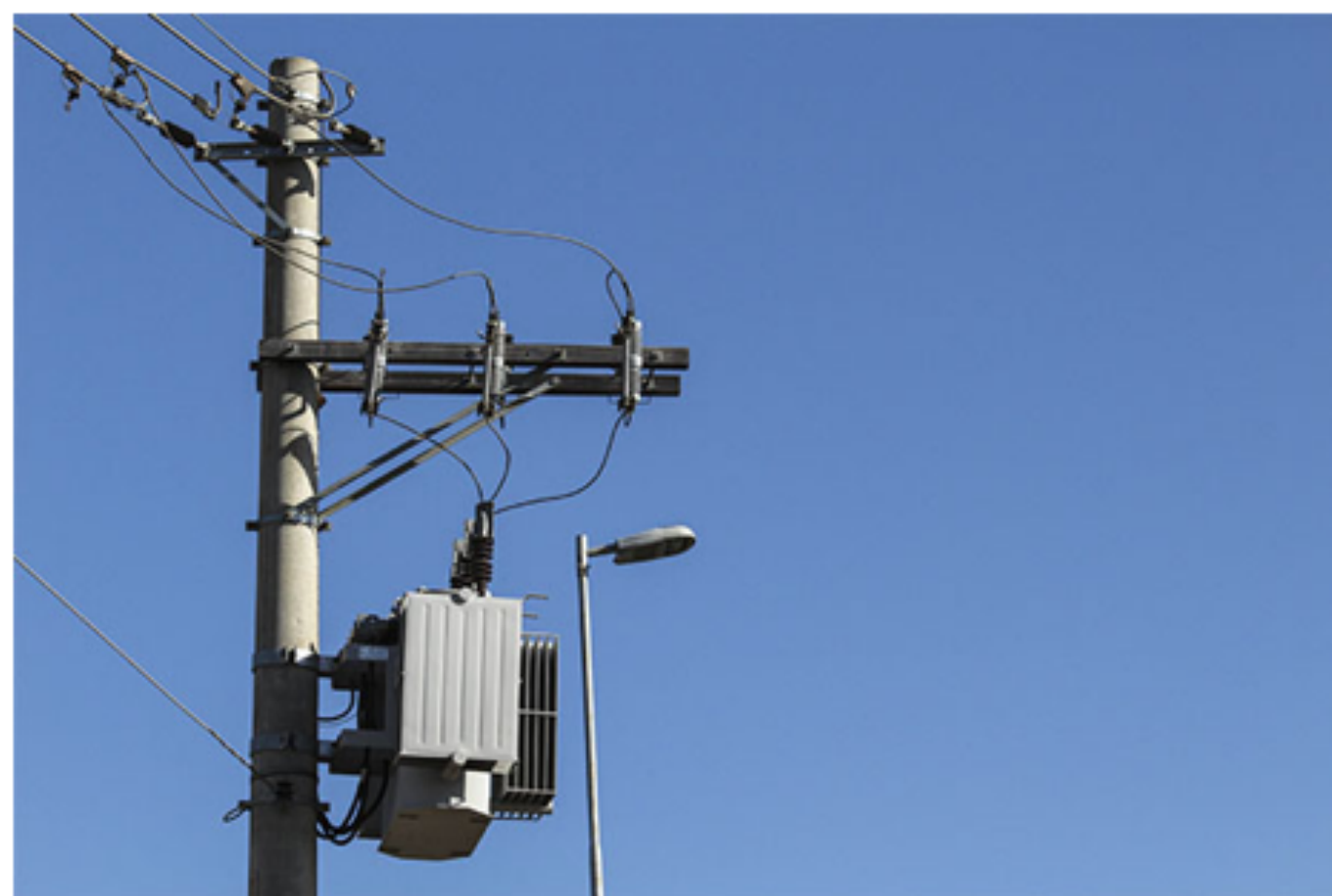
Exemplo de transformador de distribuição Fonte: http://transformadoresjundiai.com.br
