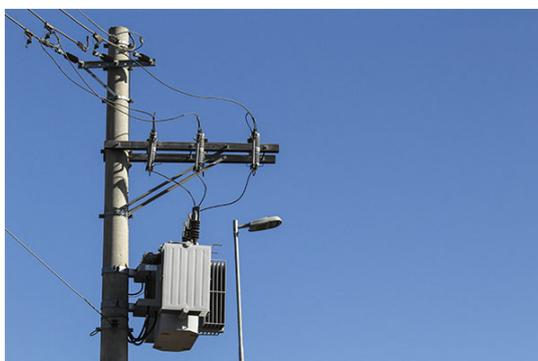
Figura 15 – Exemplos de transformadores de distribuição.
