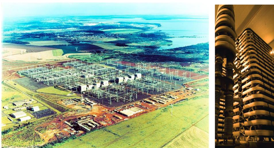
Figura 13 – Subestação de elevação e conversão ca-cc em Foz do Iguaçu- PR e quadriválvulas do sistema.
