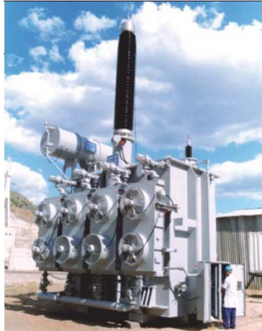
CHESF - Cia. Hidro Elétrica do São Francisco Transformador 185 MVA - 550 kV - Monofásico - Reforma
