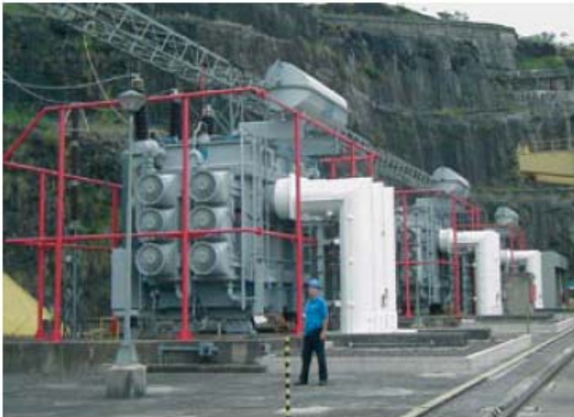
Tractebel Energia S.A - Usina Salto Osório Transformador 210 MVA - 242 kV - Reforma (3 peças)
